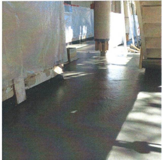
New concrete floor pour in progress.
